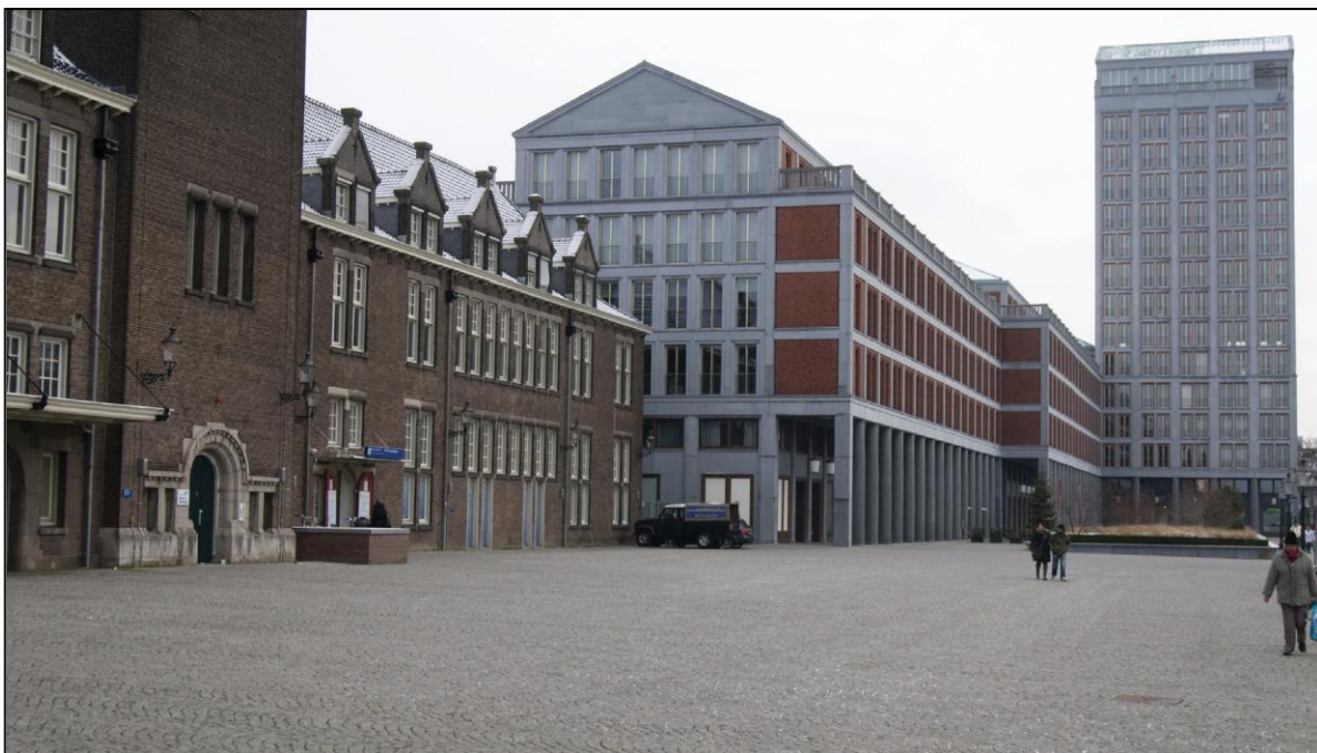
Situatie Stationsplein, na de realisatie van de ondergrondse fiets- en scooterstalling
